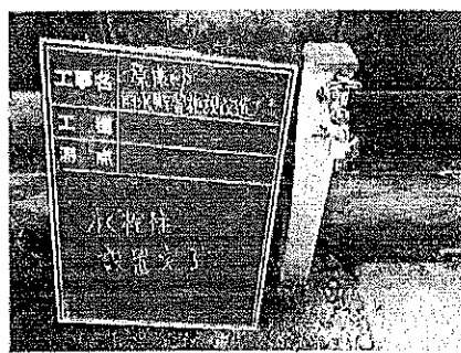
水栓設置完了
