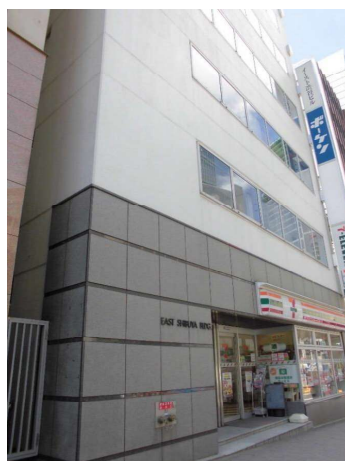
東京キャリアサポートセンターが入るビルの外観
