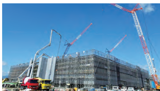
建設工事が進む新病院
