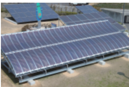
南部クリーンセンターに設置されている太陽光発電システム
