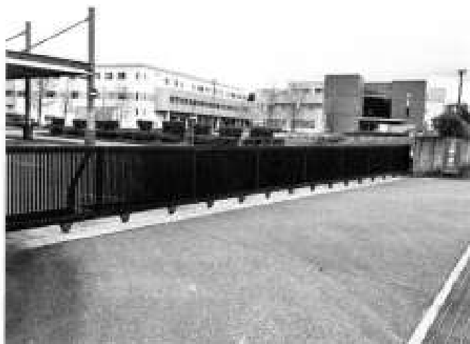
南部クリーンセンター
