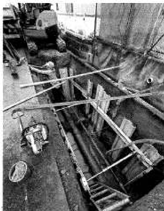
▲下水道工事の現場
