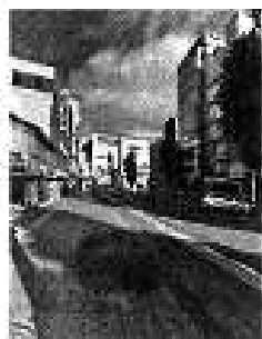
→写真② 植栽はあ るが街 路樹が ない
