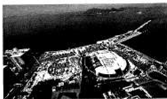
新県立体育館の建築状況
