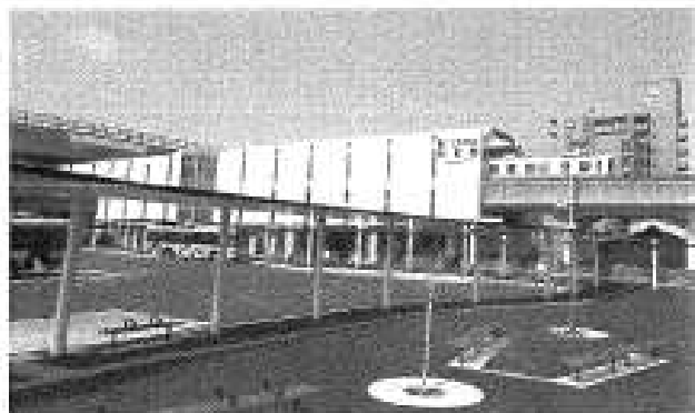
ことでん伏石駅 駅前広場
