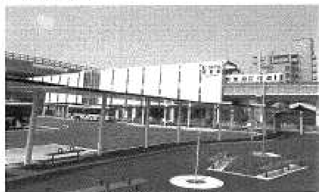
ことでん伏石駅 駅前広場
