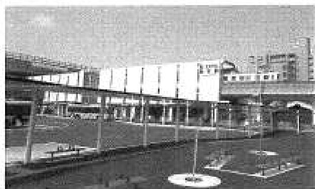
ことでん伏石駅 駅前広場
