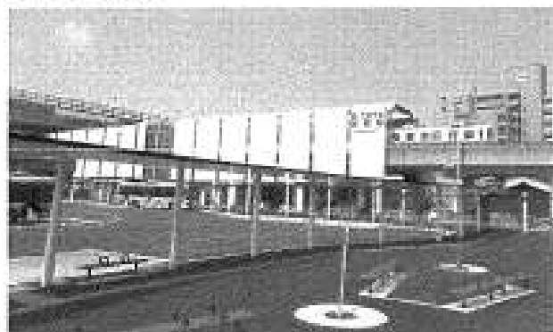
ことでん伏石駅 駅前広場
