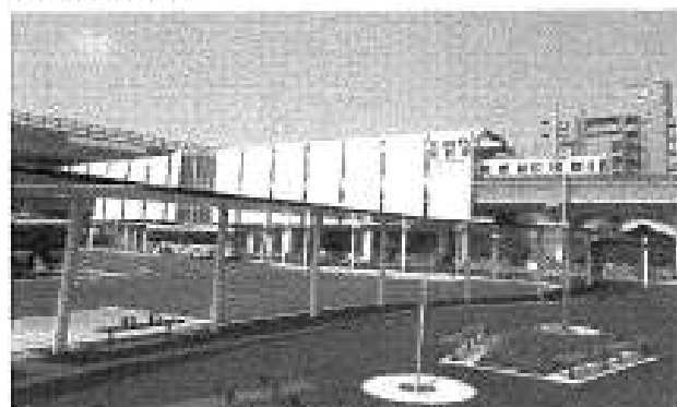
ことでん伏石駅 駅前広場
