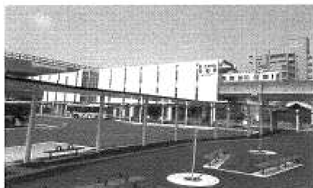
ことでん伏石駅 駅前広場
