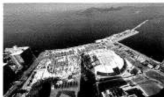
新県立体育館の建築状況
