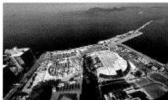
新県立体育館の建築状況
