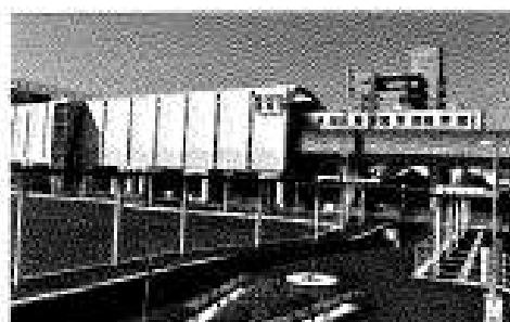
▲ことでん伏石駅 駅前広場
