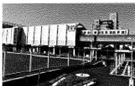
▲ことでん伏石駅 駅前広場
