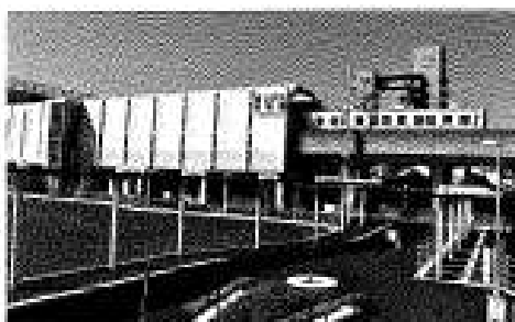
▲ことடன்伏石駅 駅前広場
