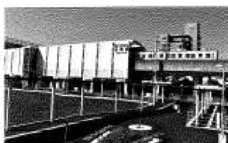
▲ことでん伏石駅 駅前広場
