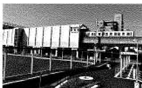
▲ことでん伏石駅 駅前広場
