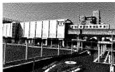
▲ことでん伏石駅 駅前広場
