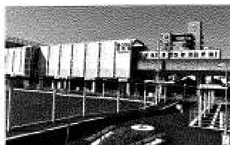
▲ことでん伏石駅 駅前広場
