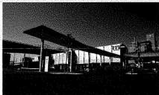
ことでん伏石駅 駅前広場
