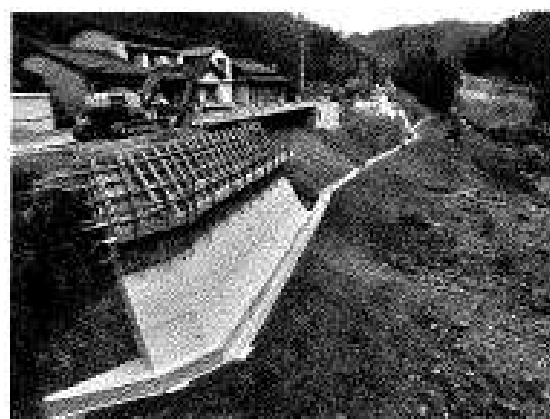
国道改良工事（落合地区）
