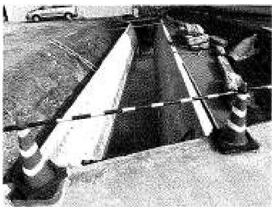
水路改良工事（香川町）
