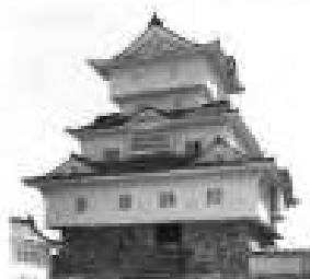
▲ 高松城天守復元工事
