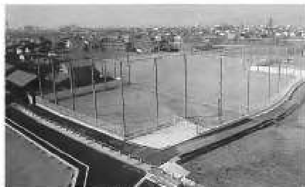
多田小学校運動場造成工事
