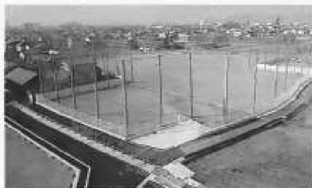
多肥小中学校運動場造成工事
