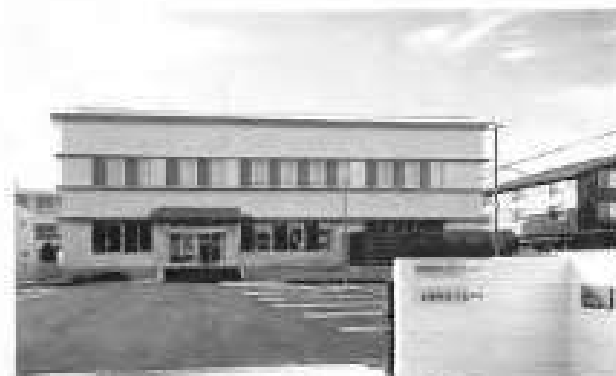
整備された木太コミュニティセンター
