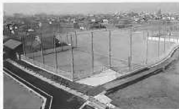
多肥小学校運動場造成工事
