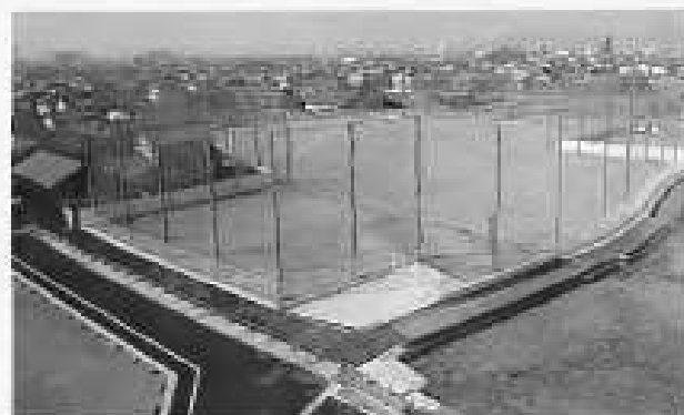
多治小中学校運動場造成工事
