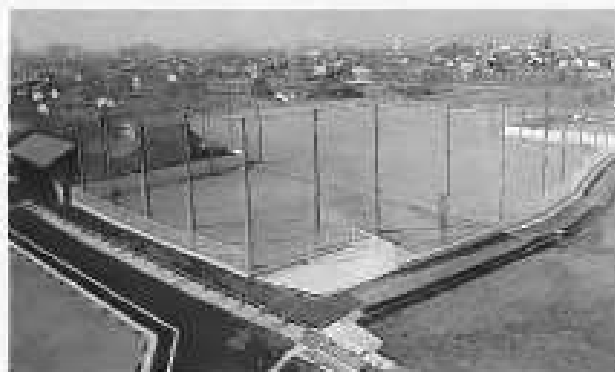
多肥小学校運動場造成工事
