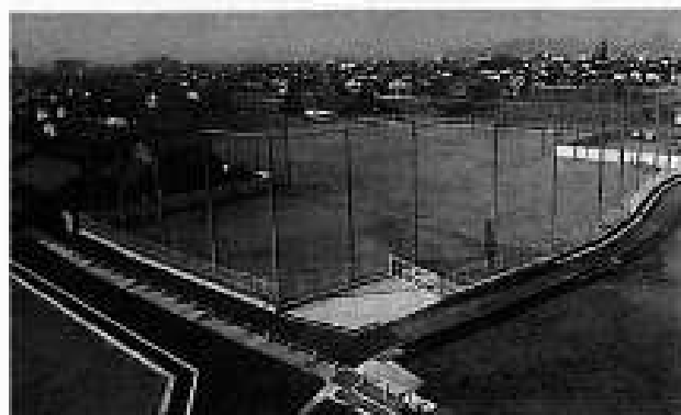
多肥小学校運動場造成工事
