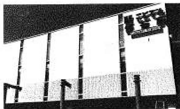
伏石駅（ことでん新駅）
