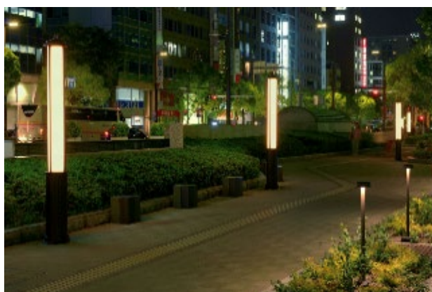
歩道空間のライティング例（神戸市）
