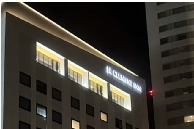
高層階に設けた箱文字のライティング例 （高松市）
