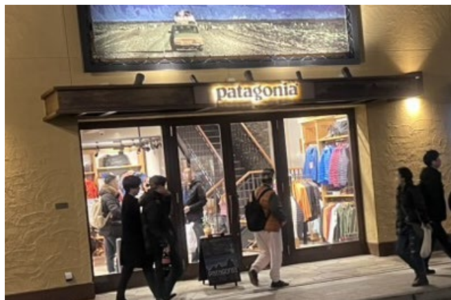
エントランス付近の箱文字のライティング例 （神戸市）
