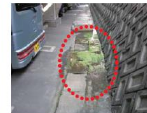
水がしみだしている擁壁 湧水部分にコケが生えている擁壁 (提供:公益社団法人 全国宅地擁壁技術協会)
