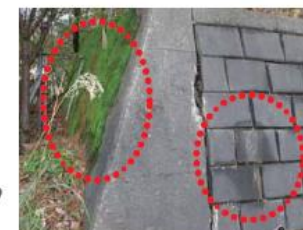
水がしみだしている擁壁 湧水部分にコケが生えている擁壁 (提供:公益社団法人 全国宅地擁壁技術協会)
