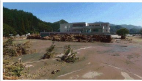
平成28年台風第10号による被害状況
