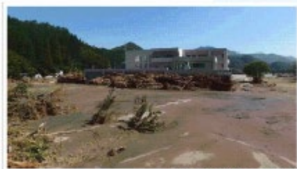
平成26年台風第10号による被害状況
