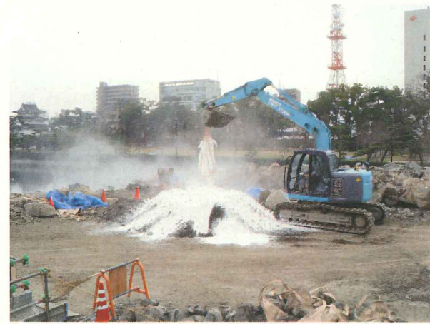
写真5 石灰混和状況
