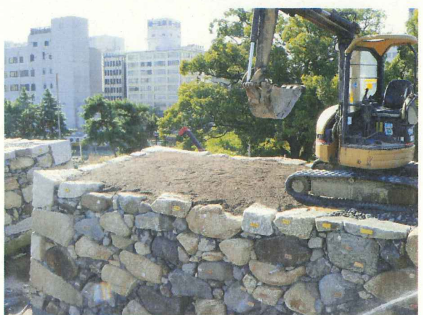
写真9 雨水対策の土舗装
