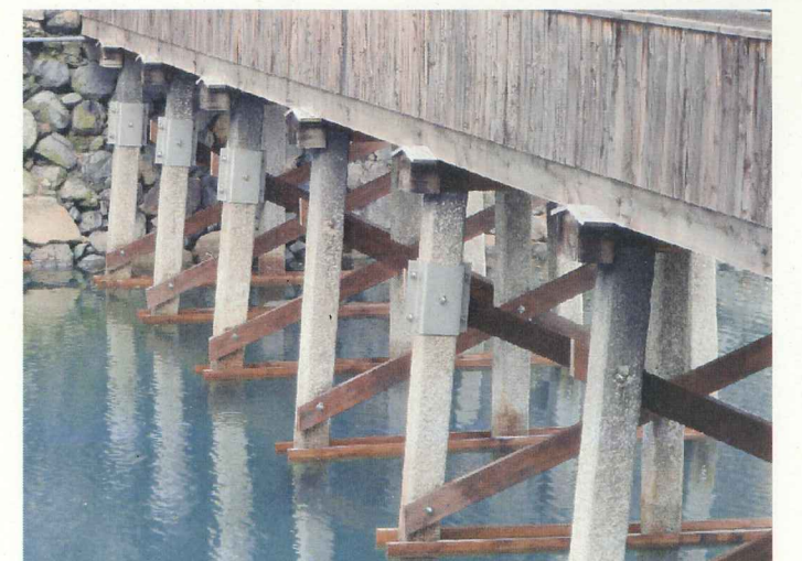
写真13 ステンレス板による橋脚補強と交換した貫材
