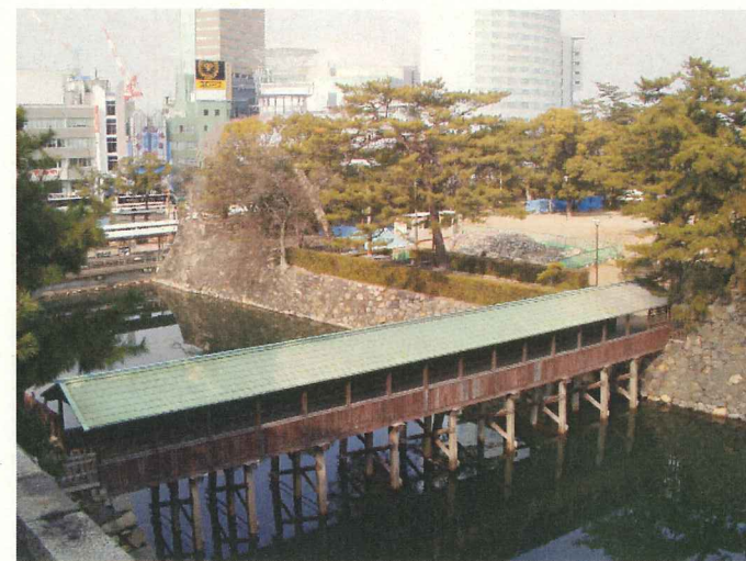
写真10 解体前の鞘橋
