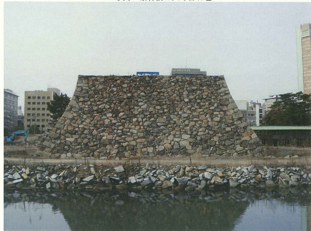
写真2 積直し工事中の天守台石垣(12月8日撮影)
