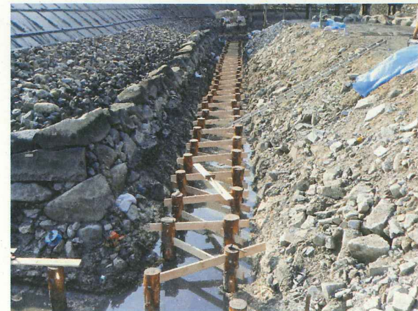
写真4 杵工施工状況
