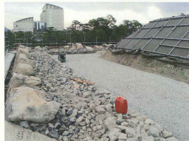
写真7 排水層施工状況
