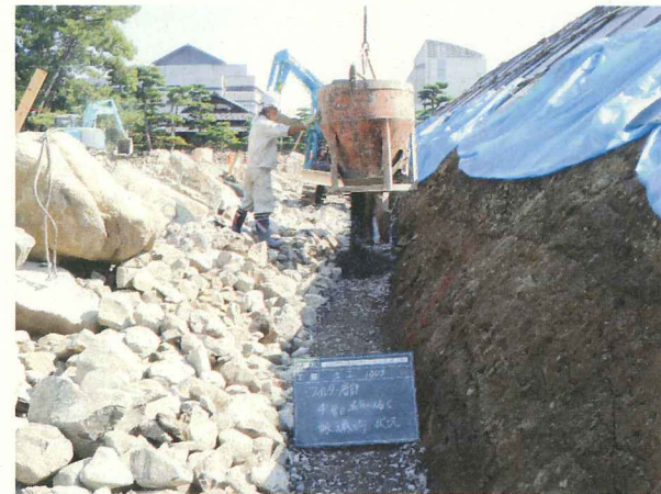
写真6 吸出し防止層施工状況
