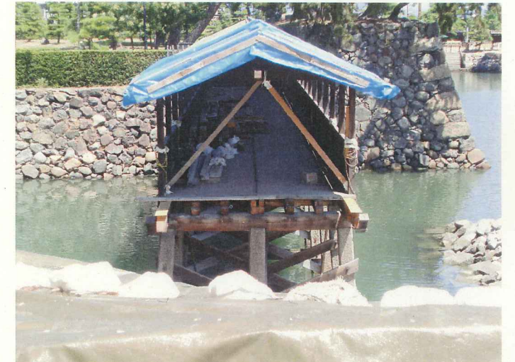
写真11 鞘橋の解体状況
