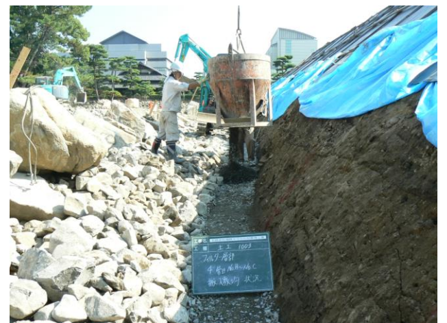
写真5 吸出し防止層設置状況
