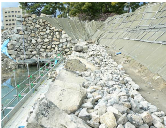
写真7 裏込め栗石設置
