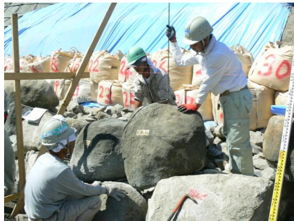
写真6 石垣積直し状況
