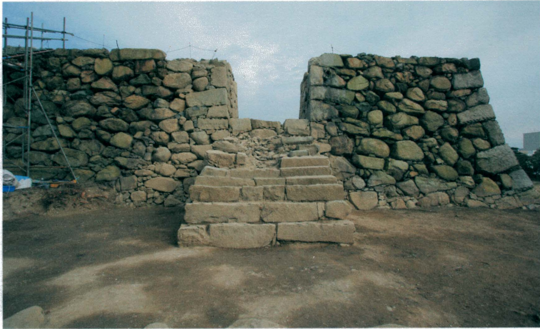
写真1 穴蔵入口(西から)
