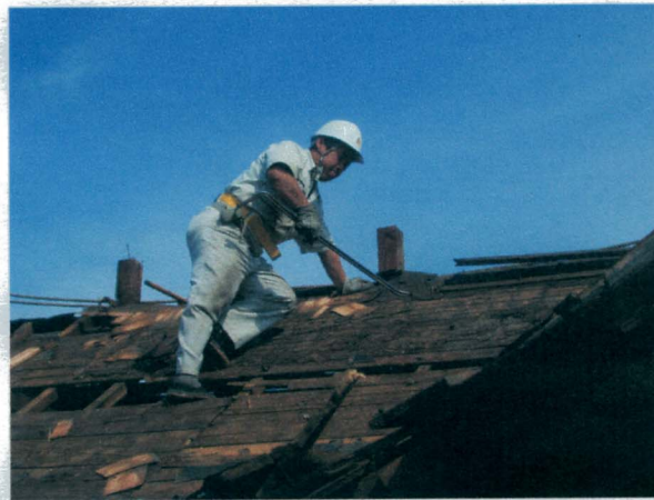
写真6 玉藻廟解体状況
