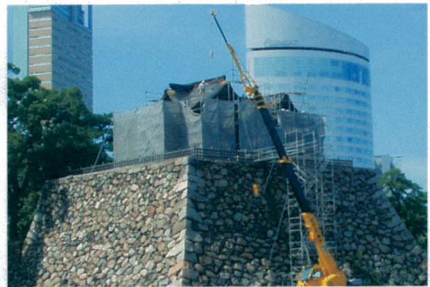
玉藻廟解体状況
