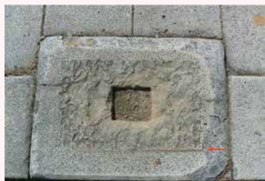
礎石に残る柱の痕跡
