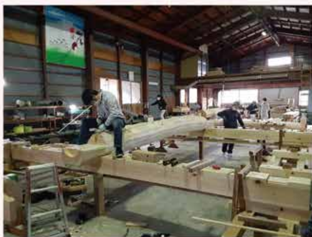
技能者の手仕事(上から瓦葺き、漆喰塗り、木材加工)
