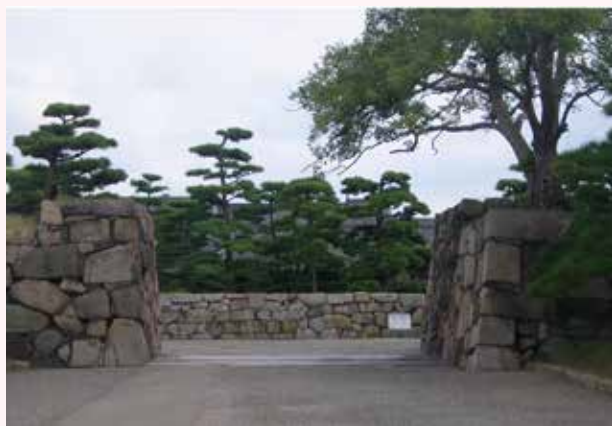
建物が焼失したあとの桜御門石垣(復元整備前)
