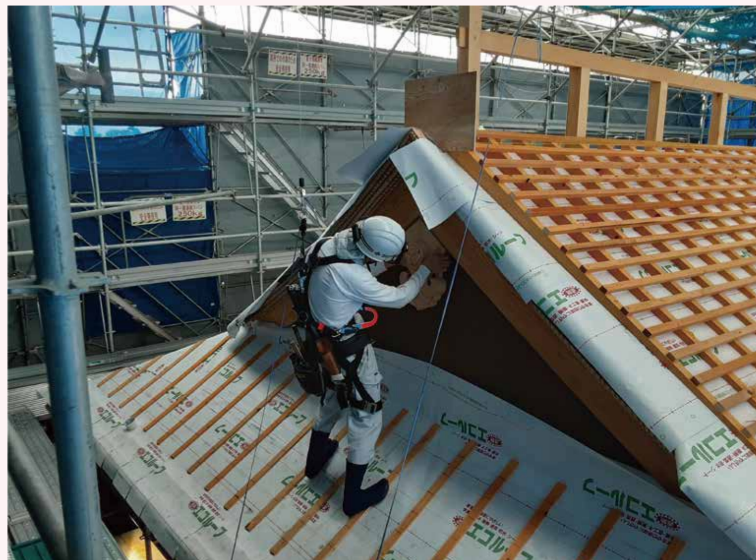
瓦の下に設置した断熱・通気・防水シート
