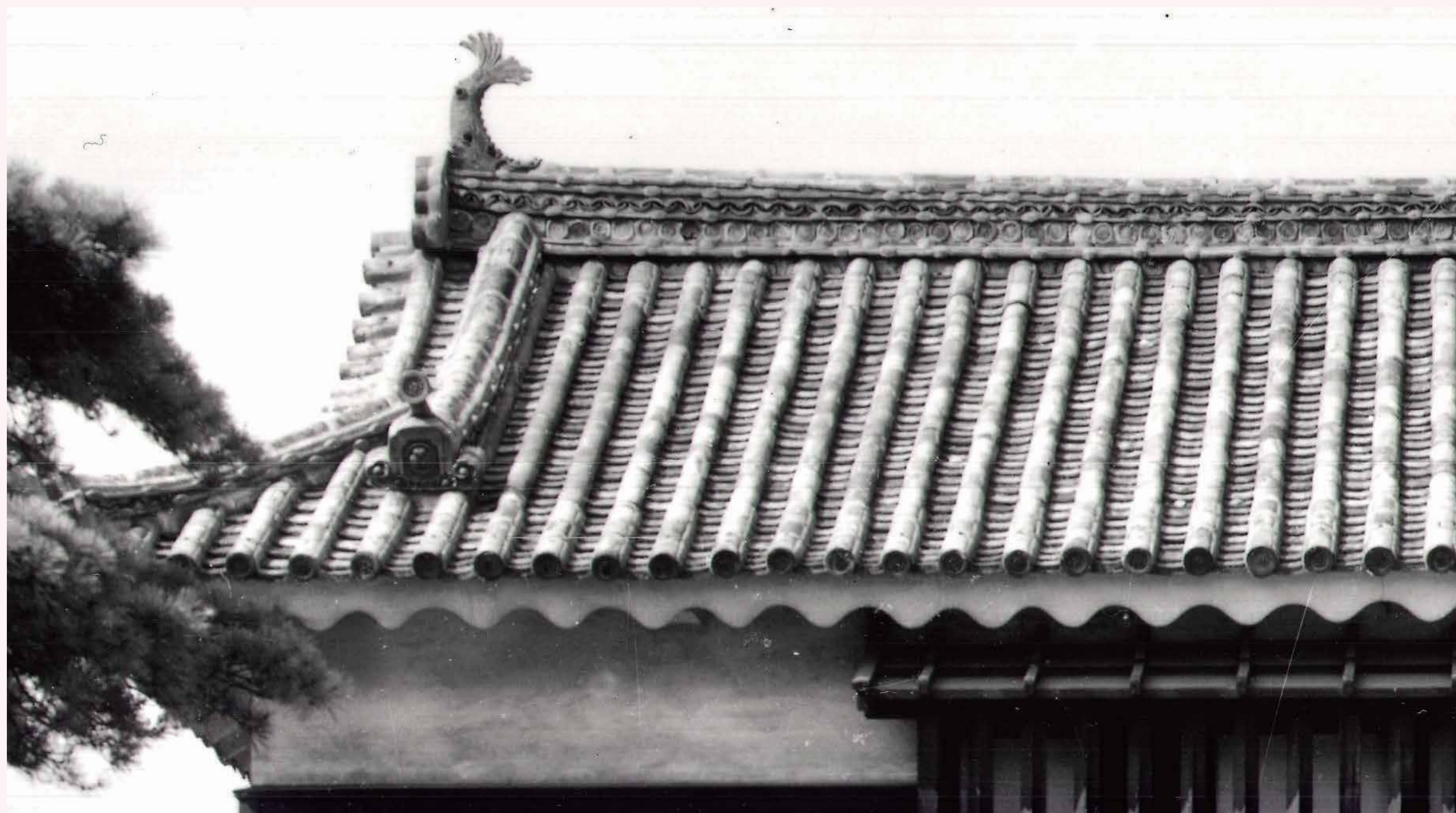
古写真からみた屋根の形状 (奈良文化財研究所提供を拡大)
