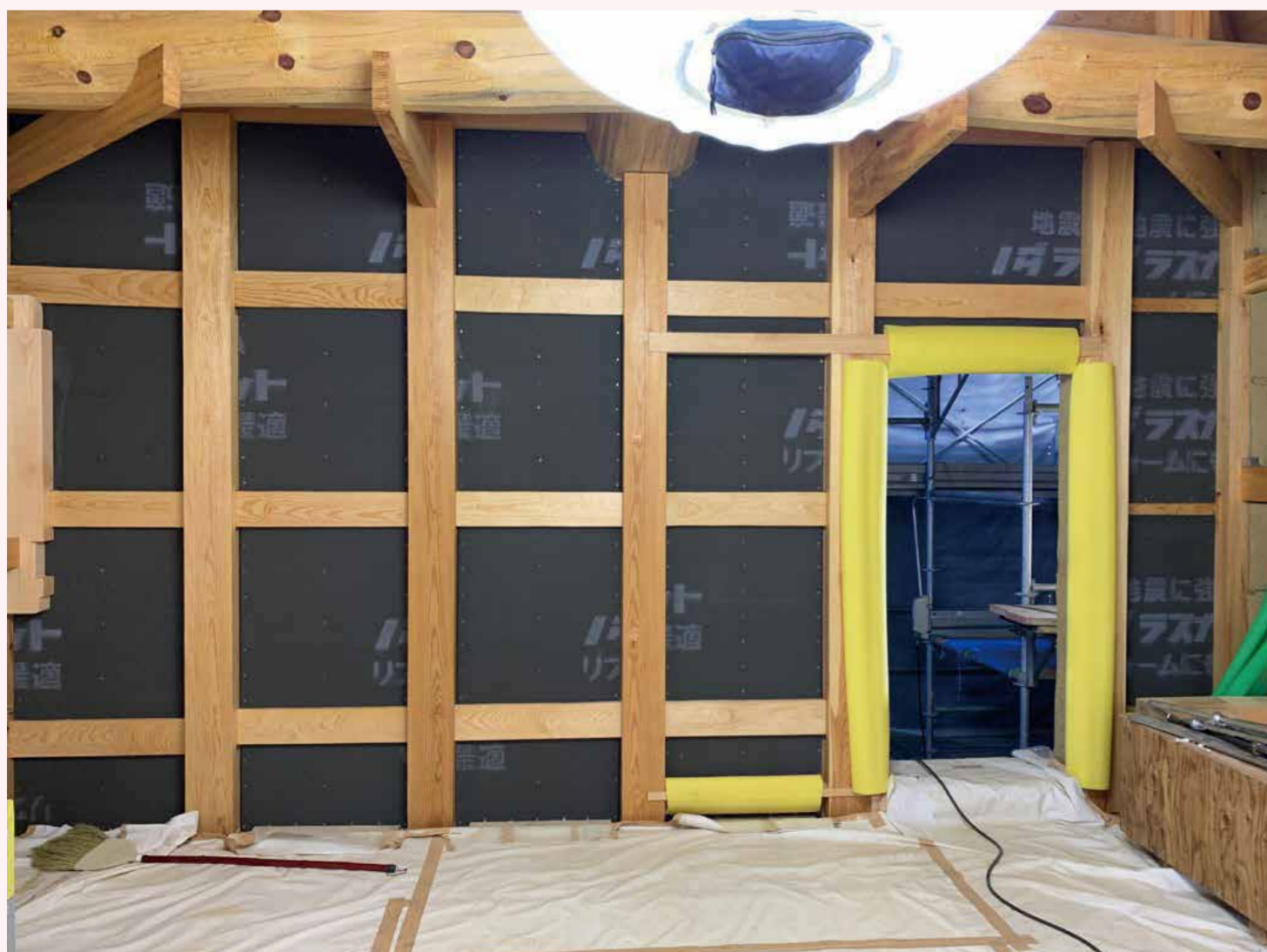
壁の中に設置した構造用合板
