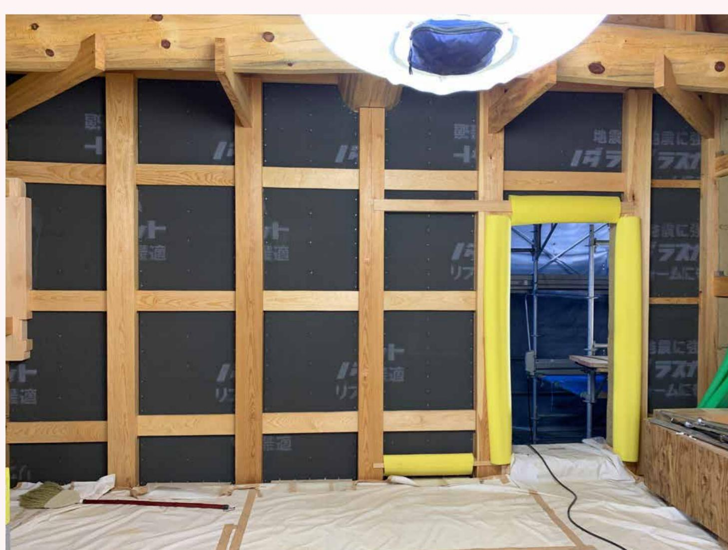
壁の中に設置した構造用合板
