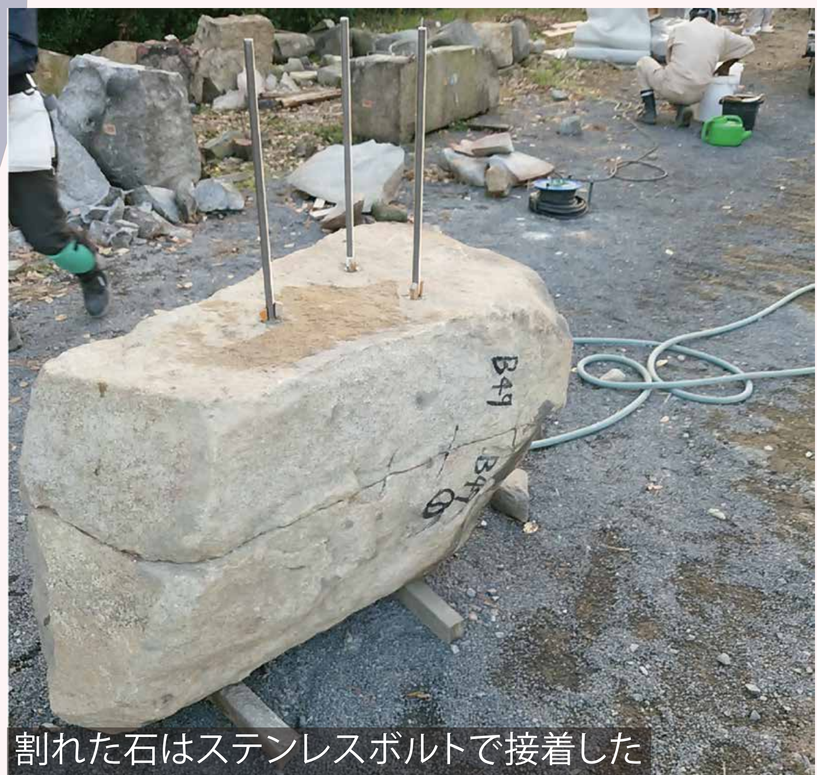
ヒビをステンレス製の鋲で補強した
