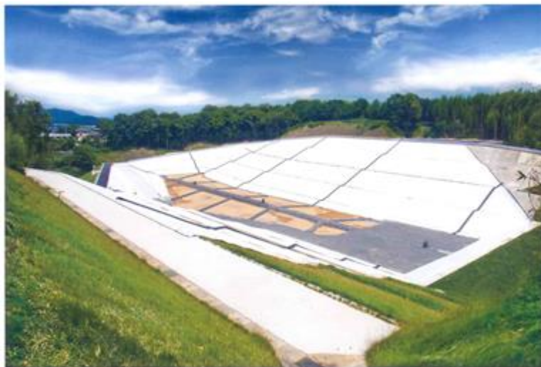
高松市一般廃棄物陶最終処分場第3処分地
