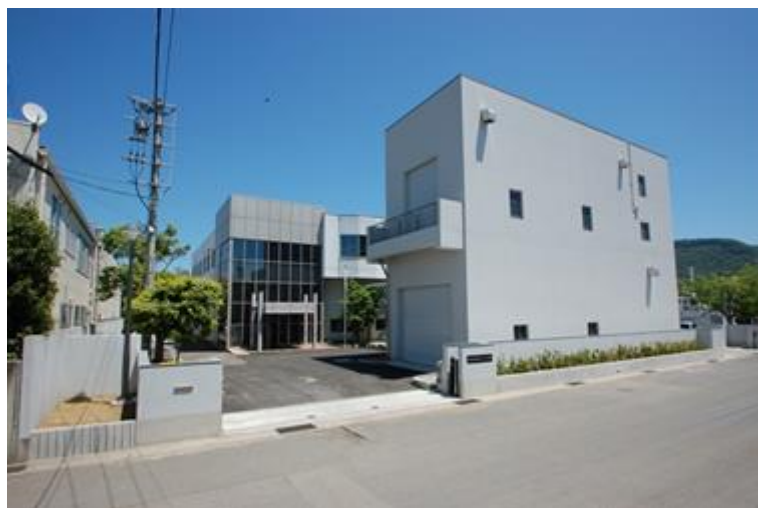
衛生センター
