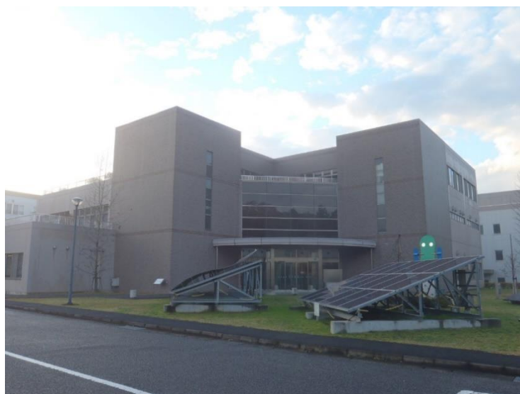
南部クリーンセンター
