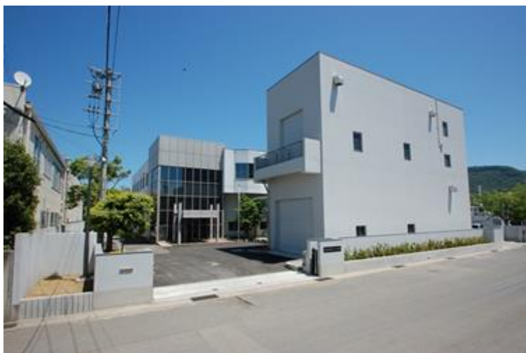
衛生センター
