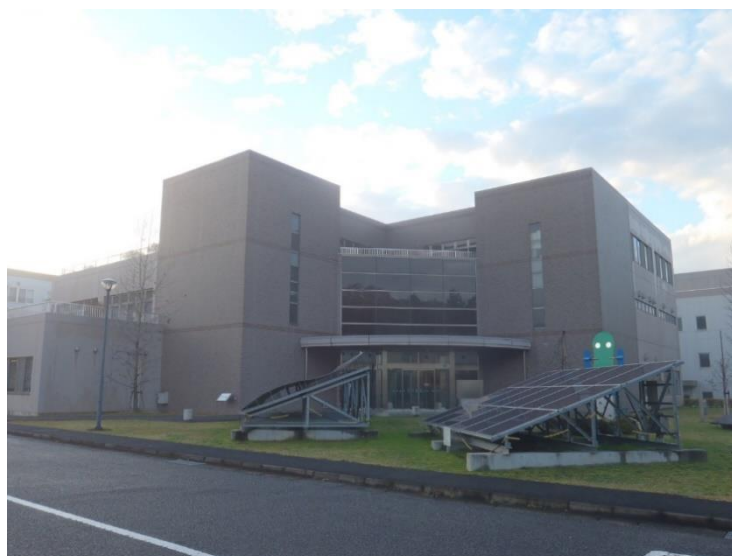
南部クリーンセンター
