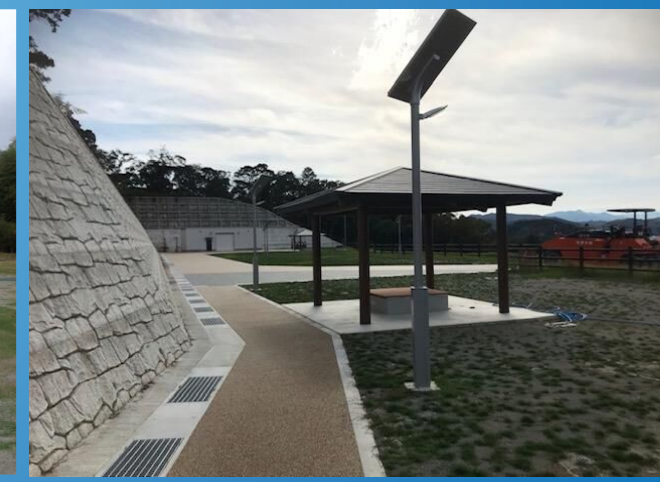
富岡東部防災公園 東屋・ソーラー照明
