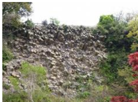
図10 高松市指定天然記念物・玄武岩の柱状節理（女木島鬼ヶ島洞窟出口）。この下に採石跡の鬼ヶ島洞窟がある。
