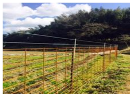
防護柵の設置
