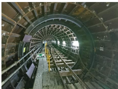
西部バイパス幹線 管きょ内(一次覆工状況)
