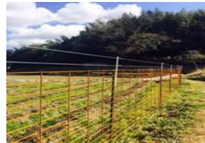
防護柵の設置
