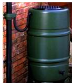
小規模貯留施設（雨水貯留施設）
