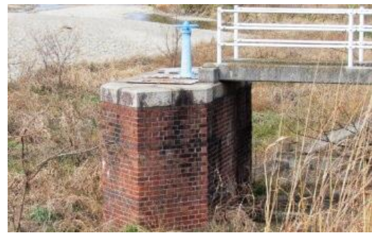
集水埋渠東方人孔 (しゅうすいまいきょとうほうじんこう)
