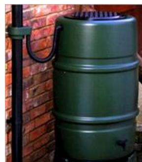
小規模貯留施設（雨水タンク）
