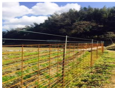
防護柵（電気柵）の設置
