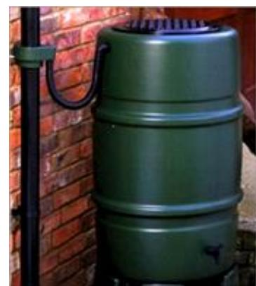
小規模貯留施設（雨水タンク）
