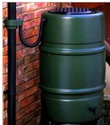
小規模貯留施設（雨水タンク）
