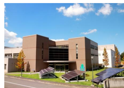
南部クリーンセンター
