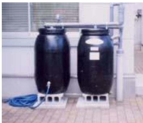
リサイクル製品の雨水タンク
