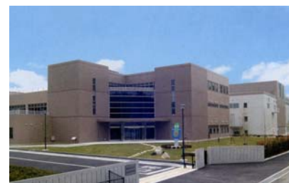
南部クリーンセンター
