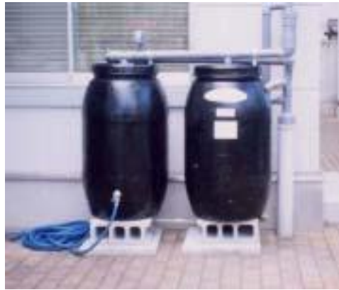
リサイクル製品の雨水タンク
