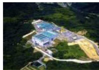
南部クリーンセンター
