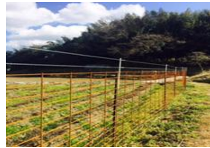
防護柵の設置
