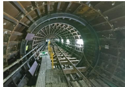
西部バイパス幹線 管きょ内(一次覆工状況)
