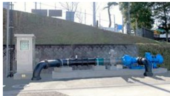
小水力発電設備
