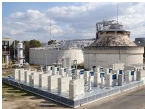
バイオマス発電設備
