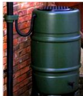
小規模貯留施設（雨水タンク）
