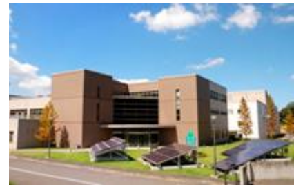
南部クリーンセンター
