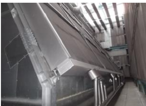
蒸気復水器（更新）
