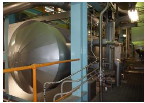
ボイラドラム（更新）
