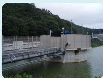
奥の池取水塔
