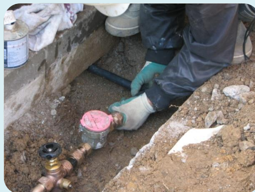
鉛管取替作業
