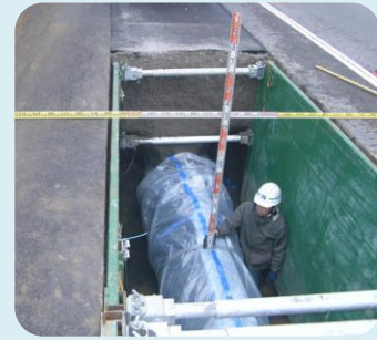
NSダクタイル鋳鉄管の布設
