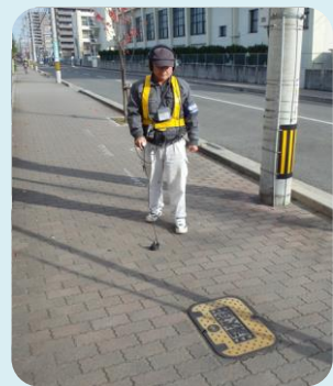
路面音聴による漏水調査
