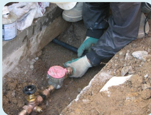
鉛管取替作業
