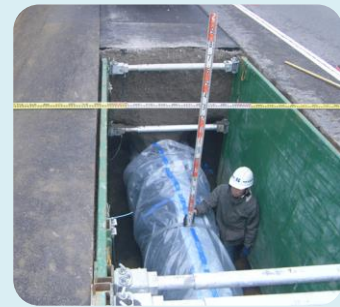
NSダクタイル鋳鉄管の布設
