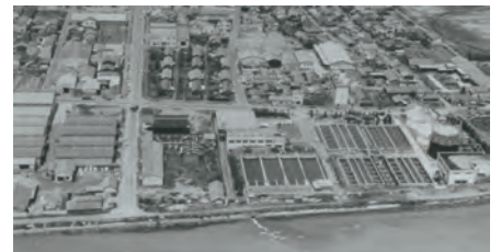
▲建設当時の福岡下水処理場（写真提供：高松市歴史資料館）
