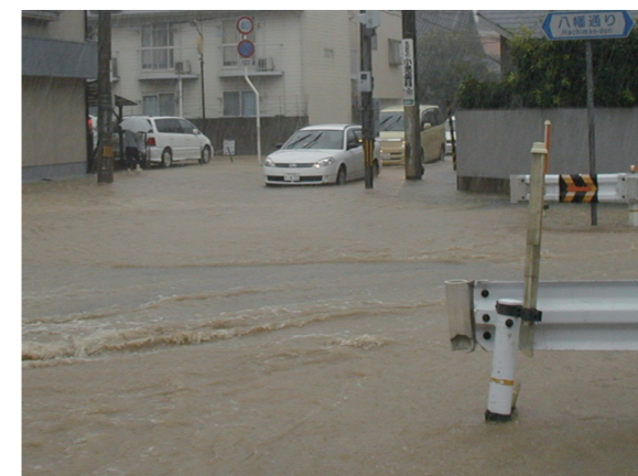
▲平成16年 台風23号により浸水被害を受けた高松市
